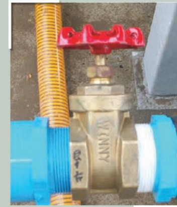
รูปที่ 9 แสดงวาล์วปรับอัตราการไหลของน้ำ
