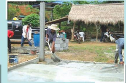
รูปที่ 6 การเทพื้นคอนกรีตเสริมไม้ไผ่ของโรงอบยางพารา
