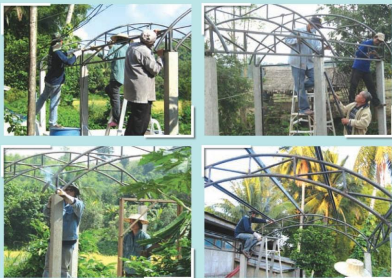
รูปที่ 8 การประกอบโครงหลังคาเข้ากับโครงสร้างโรงอบยางพารา
