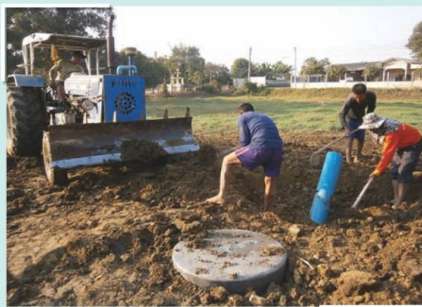
รูปที่ 1 ระบบผลิตแก๊สชีวภาพขนาด 8 ลูกบาศก์เมตร แบบกึ่งไฟเบอร์กลาส
