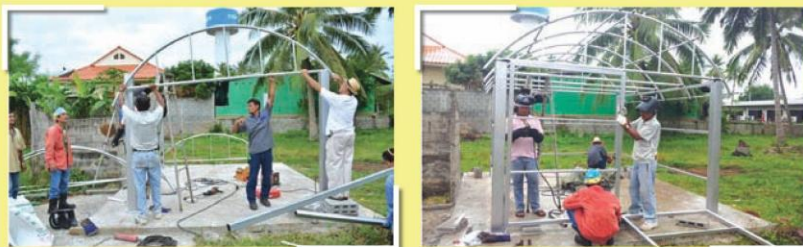
รูปที่ 6 แสดงการติดตั้งโครงหลังคา
