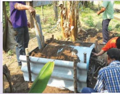
รูปที่ 9 แสดงการถมดินทรายรอบเตาเผาถ่าน 200 ลิตร แบบนอน
