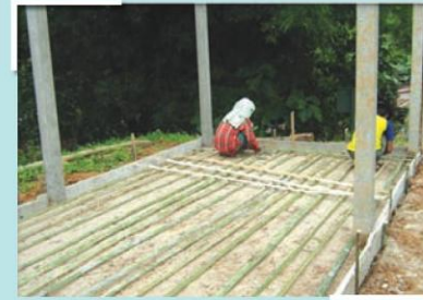
รูปที่ 6 การเทพื้นคอนกรีตเสริมไม้ไผ่ของโรงอบยางพารา
