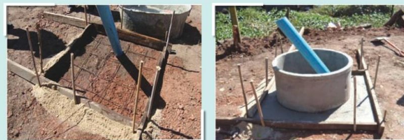
รูปที่ 10 การก่อสร้างบ่อเติมมูล
