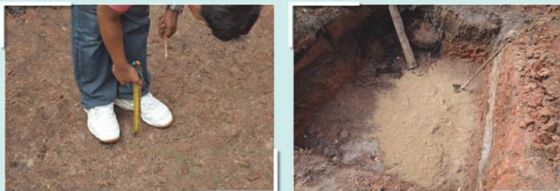
รูปที่ 3 การปรับระดับพื้น และเททรายหยาบที่กันหลุม
