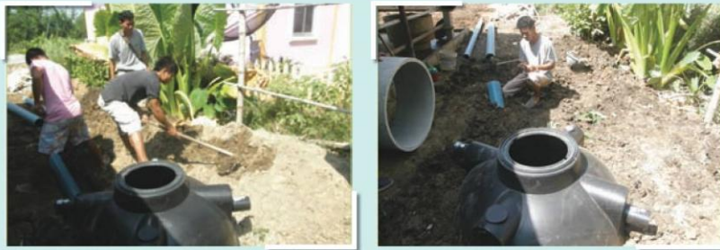
รูปที่ 12 การถมดินรอบบ่อหมัก
