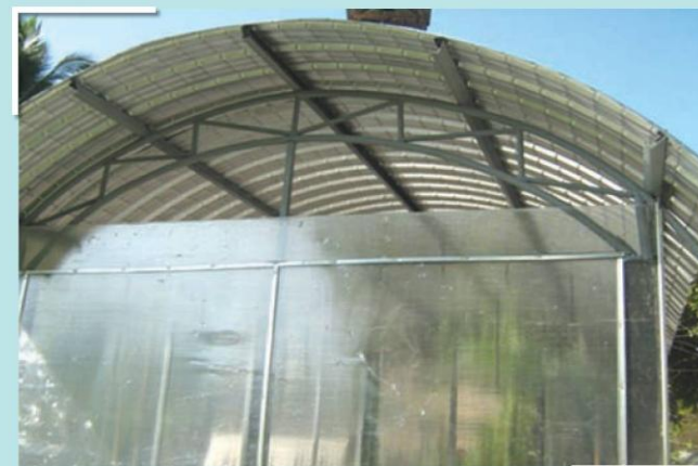
รูปที่ 10 การประกอบผนังจากแผ่น POLYCARBONATE ของโรงอบยางพารา
