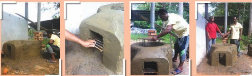
รูปที่ 8 แสดงการติดตั้งตะแกรงเหล็ก
