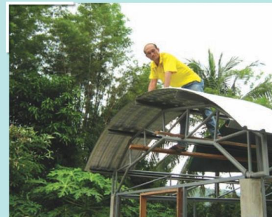
รูปที่ 9 การบุหลังคาโดยใช้แผ่นหลังคาเหล็กเมทัลชีท
