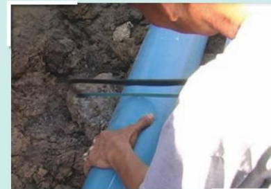
รูปที่ 11 การติดตั้งท่อป้อนมูลกลับ
