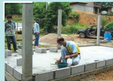
รูปที่ 7 การทำผนังก่ออิฐบล็อกฉาบเรียบของโรงอบยางพารา
