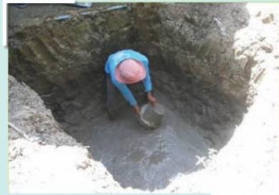
รูปที่ 8 การเทพื้นคอนกรีตหยาบที่ก้นหลุม
