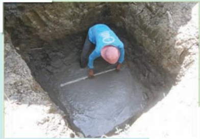
รูปที่ 8 การเทพื้นคอนกรีตหยาบที่ก้นหลุม
