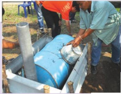
รูปที่ 9 แสดงการถมดินทรายรอบเตาเผาถ่าน 200 ลิตร แบบนอน
