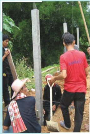
รูปที่ 5 การฝังเสาปูนสำเร็จรูป
