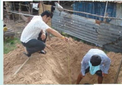
รูปที่ 7 การวางผังในการขุดบ่อหมักแก๊สชีวภาพ การขุดบ่อหมักแก๊สชีวภาพแบบถัง PE
