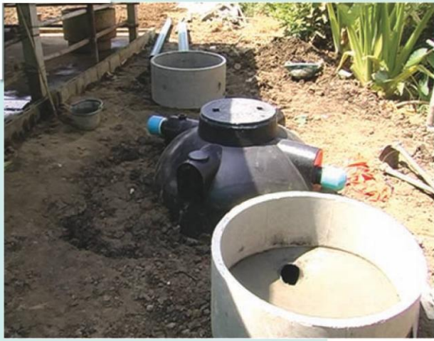
รูปที่ 1 ระบบผลิตแก๊สชีวภาพแบบถังไฟลือกัส
