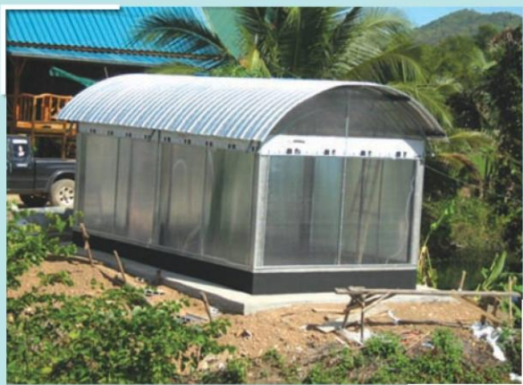
รูปที่ 12 การทาสีอะครีลิคดำ บริเวณผนังฉาบปูนเรียบของโรงอบแห้งยางพารา
