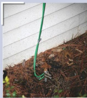
รูปที่ 17 การติดตั้งอุปกรณ์ในตัวพร้อมบาร์ ลากสายจาก Ground Rod ไปยังแผงโซลาร์เซลล์ทุกแผง และอุปกรณ์อื่น ๆ ที่จำเป็นต้องลงกราวด์
