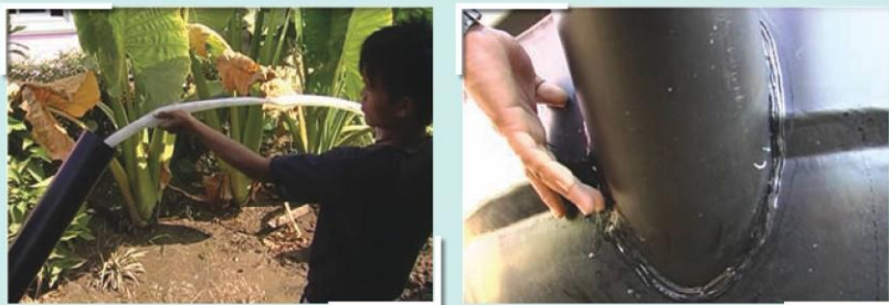
รูปที่ 1 การตรวจสอบรอยรั่วที่ท่อเติมและท่อล้น
