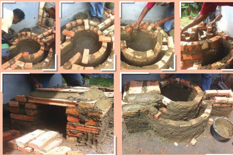
รูปที่ 4 แสดงการทำช่องระบายควันและช่องใส่เชื้อเพลิง
