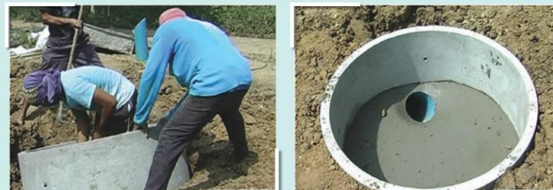
รูปที่ 9 การก่อสร้างบ่อมูลล้น
