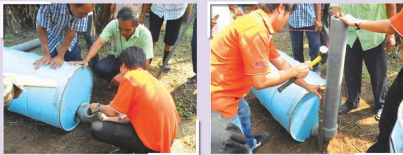
รูปที่ 7 แสดงการติดตั้งท่อและกล่องฮิเมนต์โยหิน
