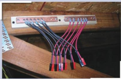
รูปที่ 16 บาร์บวก และบาร์สบ จะช่วยให้การเดินสายเคเบิลจำนวนมากทำได้ง่ายขึ้น
