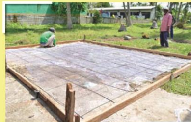
รูปที่ 3 แสดงการเทคอนกรีต
