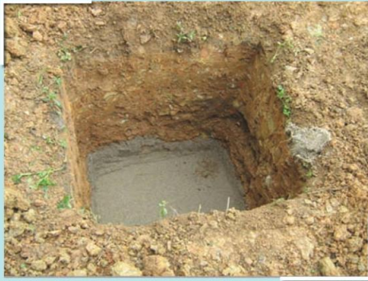
รูปที่ 4 การขุดหลุม เพื่อฝังเสา
