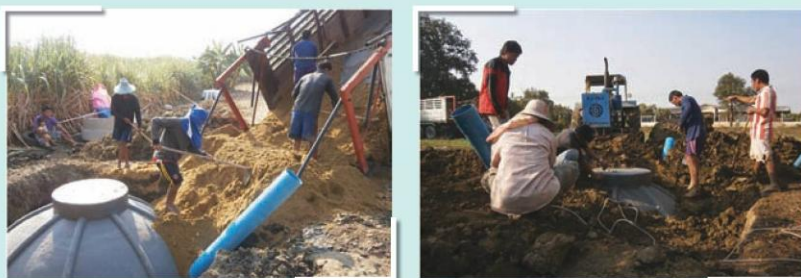
รูปที่ 8 การถมดินรอบบ่อแก๊สชีวภาพแบบไฟเบอร์กลาส
