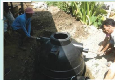
รูปที่ 9 การติดตั้งถังหมักแบบ PE
