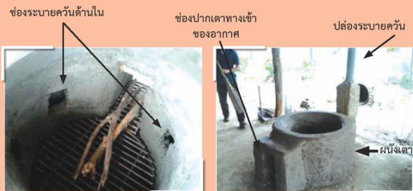
รูปที่ 1 แสดงส่วนประกอบและโครงสร้างเตาฟืนนาซุมเห็ด
