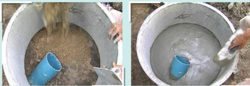
รูปที่ 13 การก่อสร้างบ่อมูลล้น
