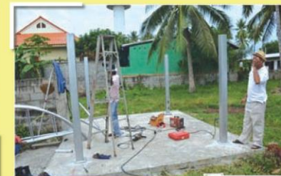
รูปที่ 4 แสดงการติดตั้งเสา
