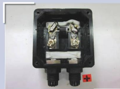
จุดต่อสายอยู่ด้านในเห็นได้ชัดเจน โดยจะต้องลอดสายผ่านทาง Cable Gland ที่อยู่ด้านล่าง
