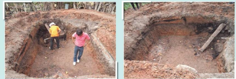
รูปที่ 2 การวางผัง และการขุดบ่อหมักแก๊สชีวภาพ
