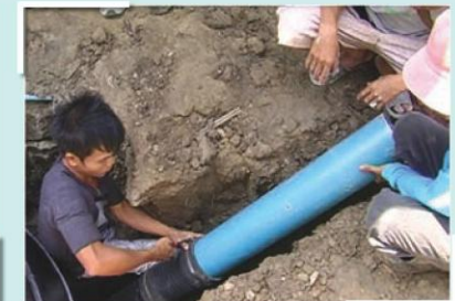
รูปที่ 11 การติดตั้งท่อป้อนมูลกลับ
