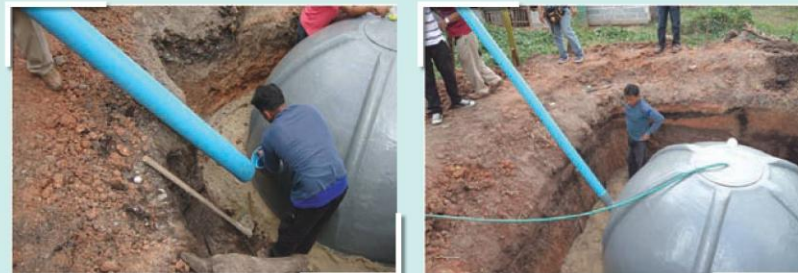
รูปที่ 5 การติดตั้งท่อเติมมูล
