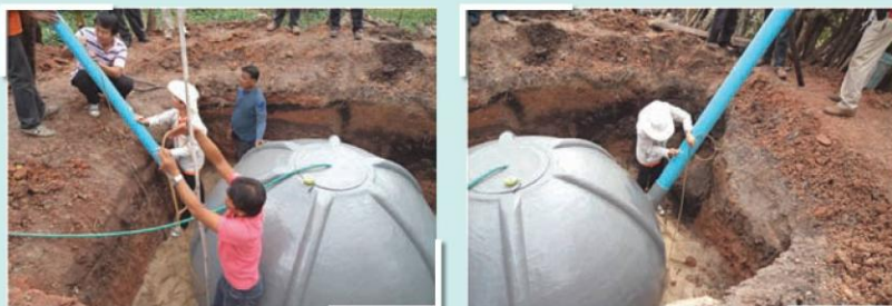
รูปที่ 7 ตำแหน่งของระดับท่อเติม และท่อล้น
