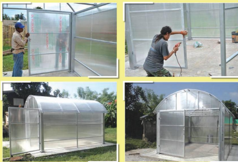
รูปที่ 7 แสดงการติดตั้งผนัง
