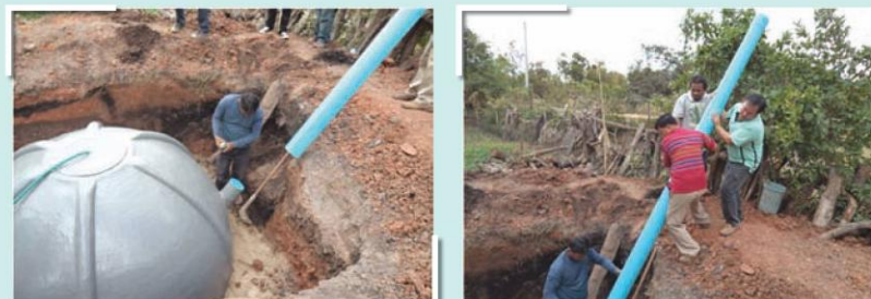
รูปที่ 6 การติดตั้งท่อมูลล้น
