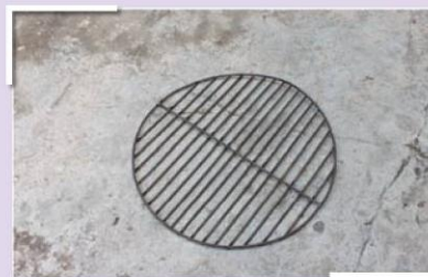
รูปที่ 21 แสดงการติดตั้งตะแกรงรองฟืน
