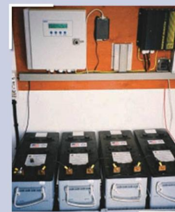
ติดตั้งแบตเตอรี่ในที่ที่มีอากาศถ่ายเท
