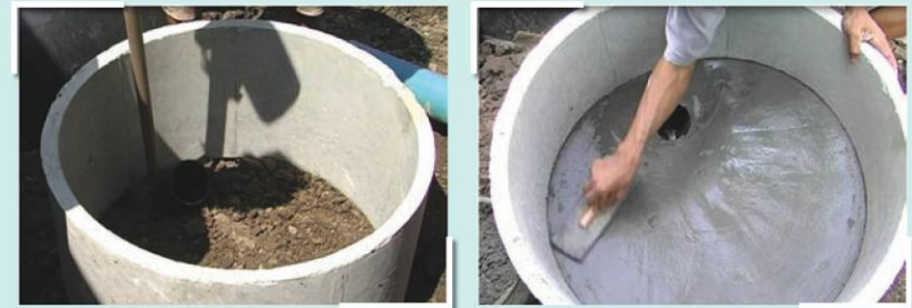
รูปที่ 14 การก่อสร้างบ่อเติมมูล
