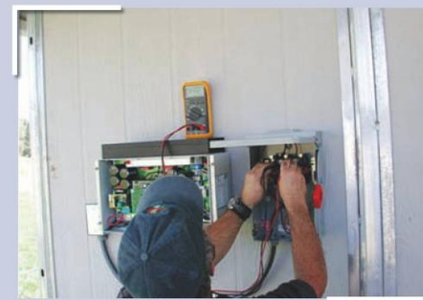
รูปที่ 22 ทดสอบก่อนการเปิดใช้งาน โดยวัดแรงดันเพื่อตรวจสอบความถูกต้อง
