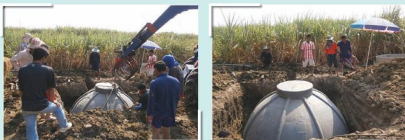
รูปที่ 4 การติดตั้งบ่อหมักแก๊สชีวภาพแบบไฟเบอร์กลาส
