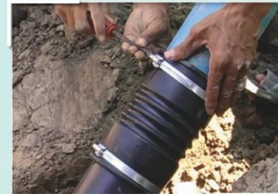
รูปที่ 10 การติดตั้งท่อเติมมูล
