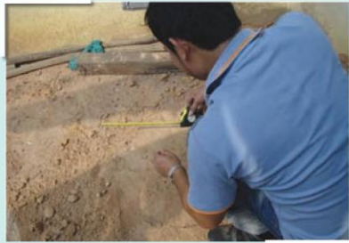
รูปที่ 7 การวางผังในการขุดบ่อหมักแก๊สชีวภาพ การขุดบ่อหมักแก๊สชีวภาพแบบถัง PE
