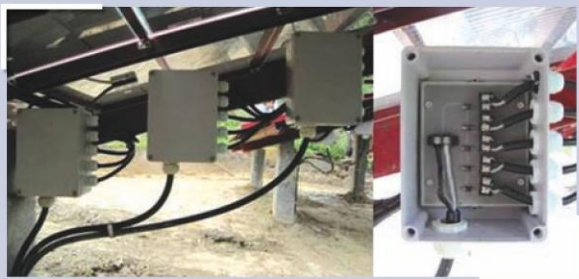
รูปที่ 24 แสดงการตรวจสอบจุดเชื่อมต่อ
