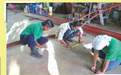
รูปที่ 5 แสดงการทำโครงหลังคา
