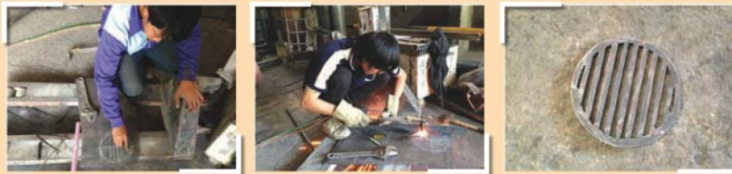
(3) ตัดเหล็กเพื่อทำตะแกรงดักขยะ
