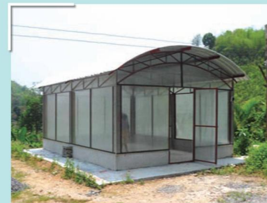
รูปที่ 2 ส่วนประกอบหลักของโรงอบแห้งพลังงานแสงอาทิตย์สำหรับยางพาราประกอบ
