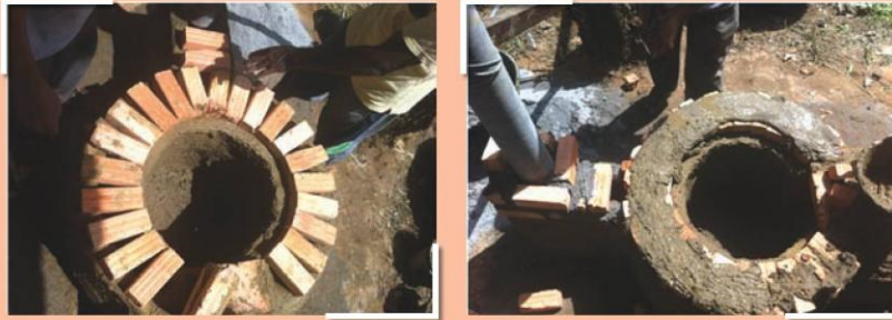
รูปที่ 6 แสดงการติดตั้งปล่องระบายควัน
