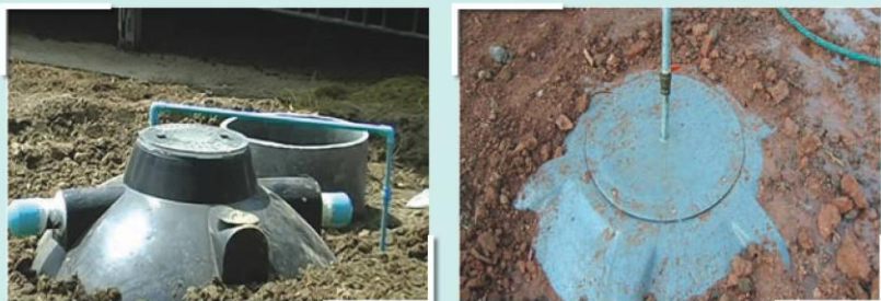
รูปที่ 1 การต่อท่อน้ำแก๊สโดยใช้ท่อ PVC
