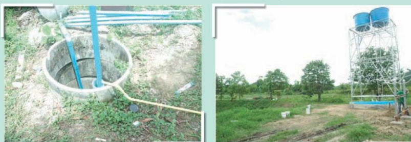
(3) ติดตั้งระบบท่อ วาล์วจากเครื่องสูบน้ำไปยังแทงค์น้ำ
