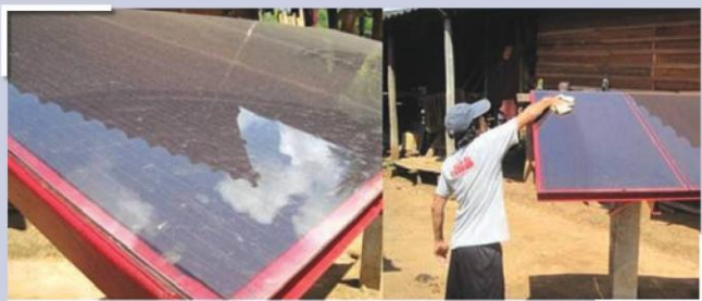
รูปที่ 23 แสดงการทำความสะอาดแผงเซลล์แสงอาทิตย์
