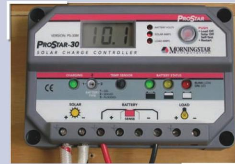
รูปที่ 21 ติดตั้งสายจากแบตเตอรี่เป็นอันดับแรก แล้วจึงต่อสายจากแผงโซลาร์เซลล์
