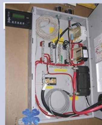
การติดตั้งอุปกรณ์ในตู้พร้อมบาร์
