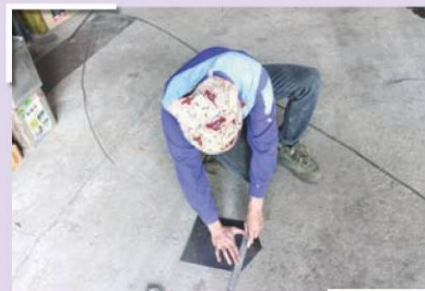
รูปที่ 20 แสดงการทำแผ่นปิดควบคุมอากาศ
