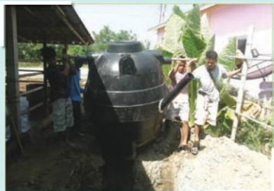
รูปที่ 9 การติดตั้งถังหมักแบบ PE
