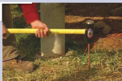
ตอก Ground Rod ลงพื้นดินบริเวณที่มีความชื้นสูง
