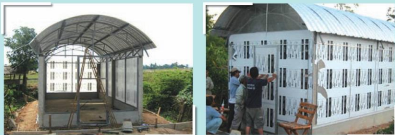
รูปที่ 11 การประกอบผนังด้านหน้าและประตู ของโรงอบยางพารา
