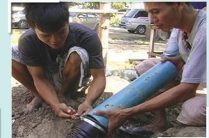
รูปที่ 10 การติดตั้งท่อเติมมูล
