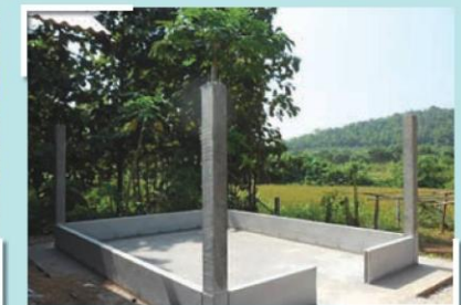
รูปที่ 7 การทำผนังก่ออิฐบล็อกฉาบเรียบของโรงอบยางพารา
