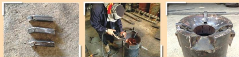
(15) ติดตั้งเสารองกระทะ
